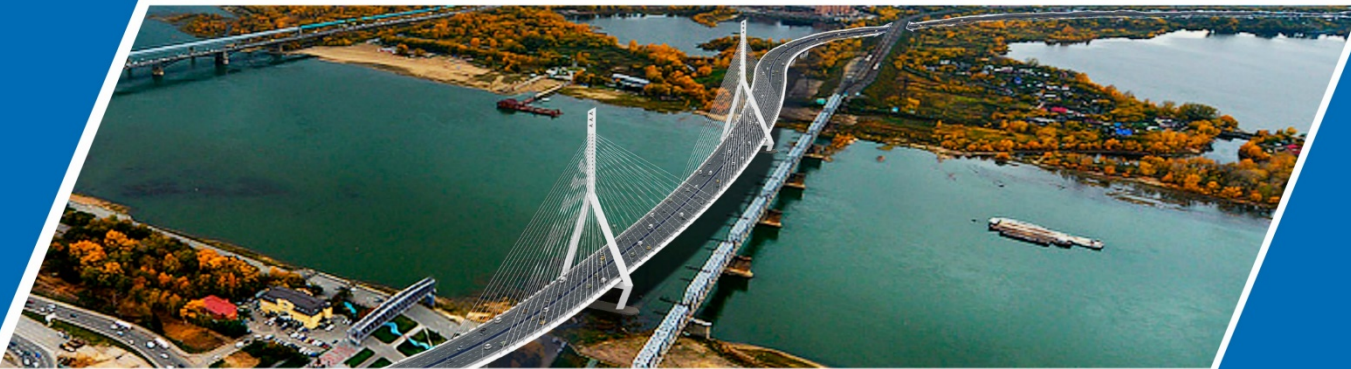
Строительство четвертого моста через р. Обь в г. Новосибирске
